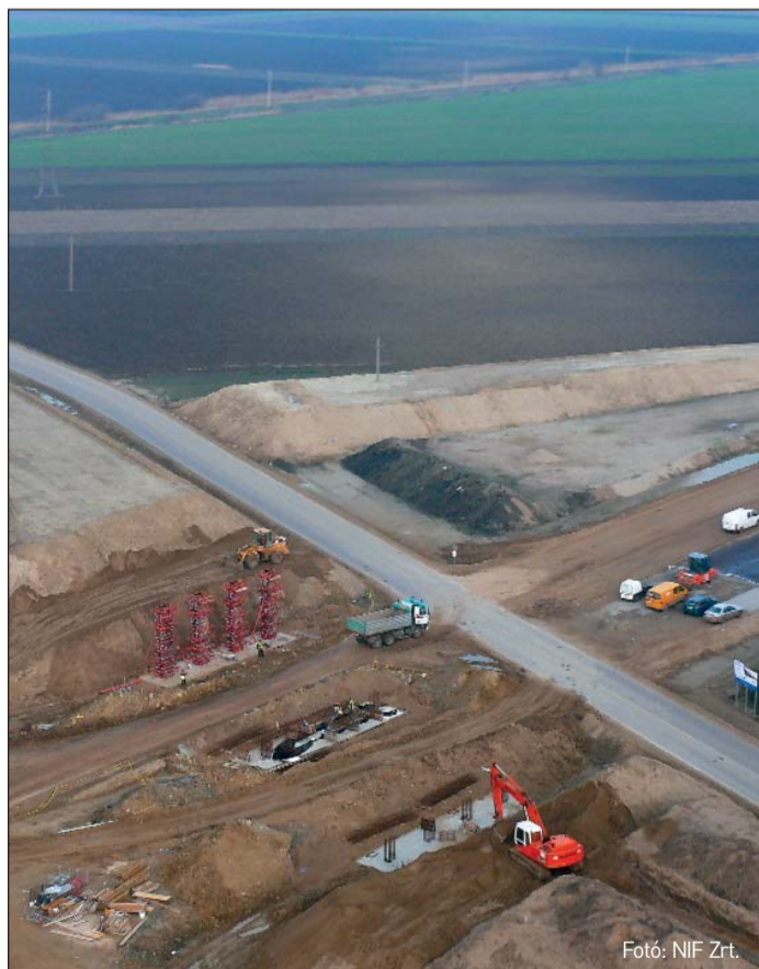
Az M43-as autópálya építése
